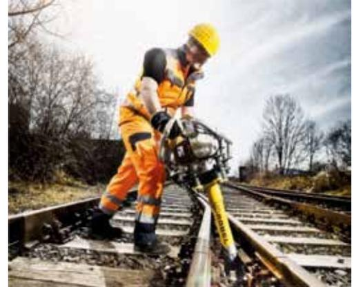
manteniendo intacto el balasto y durmientes, para luego dejar la vía lista para un nuevo tráfico. Se suma su patentada forma de desacoplamiento por 2 niveles, la que reduce de manera significativa las vibraciones en el trabajo del Operador.
