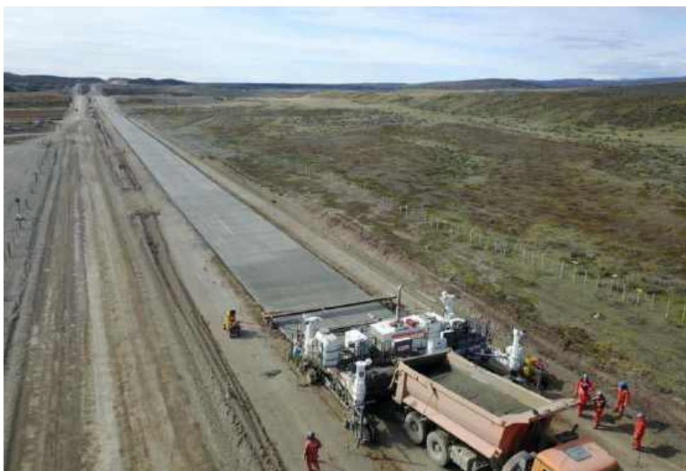
Figura A7- 2. Obras de pavimentación vial en la región de Magallanes
